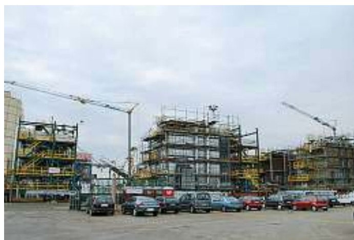
Pronti a salpare Lo stabilimento Turmech al porto di Taranto
